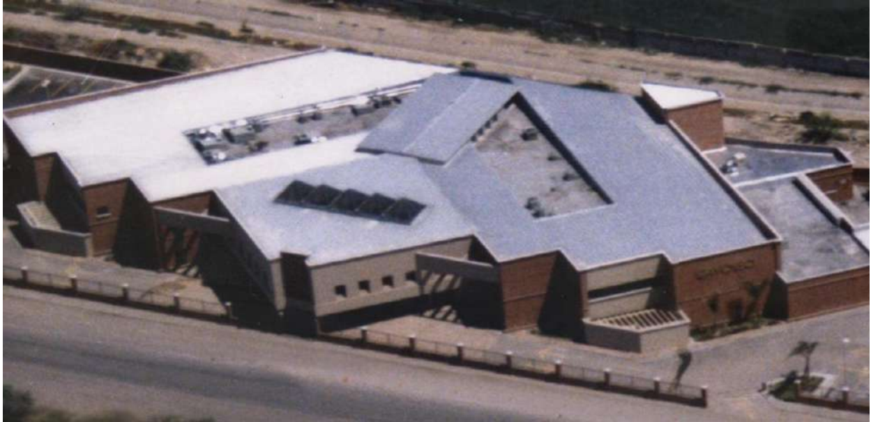
Construcción de la funeraria y mausoleo Gayosso en Torreón, Coah
