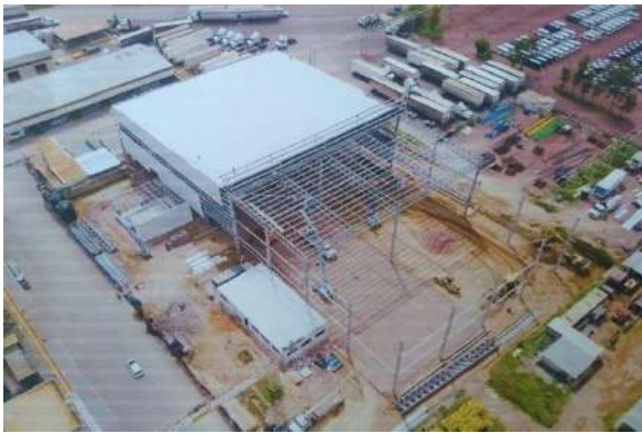
Construcción de Naves Industriales de 5500 m 2 y patios de 8500 m 2 para la Planta Fundición III Nissan Mexicana en Aguascalientes, Ags.
